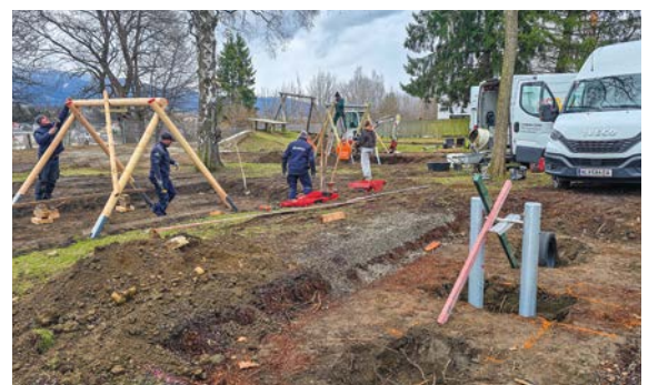
Fachgerechte Modernisierungsarbeiten im Europapark.
