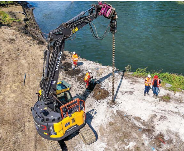
Mittels Bohrungen wurde der Boden auf mögliche Kampfmittel sondiert.
